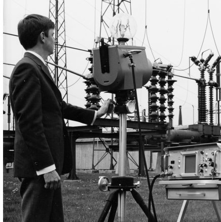
Figura 14.2 1969: Thermovision modelo 661 de 1969. La cámara pesaba unos 25 kg, el osciloscopio 20 kg y el trípode 15 kg. El usuario también necesitaba un generador de 220 V CA y un recipiente de 10 litros con nitrógeno líquido. A la izquierda del osciloscopio se puede observar el accesorio Polaroid (6 kg).
